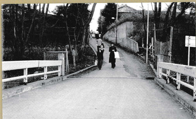
▲宅添橋 1978年12月撮影 (写真提供: せんがわ 21)
